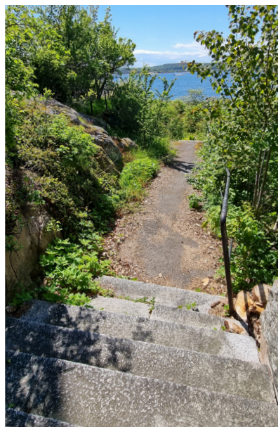
Stentrappa som ska bevaras.
