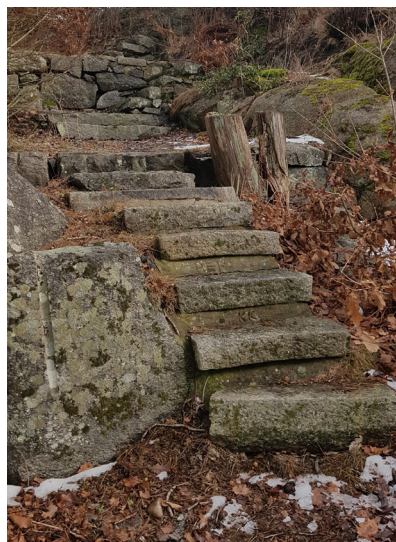
Stentrappa som ska bevaras.
