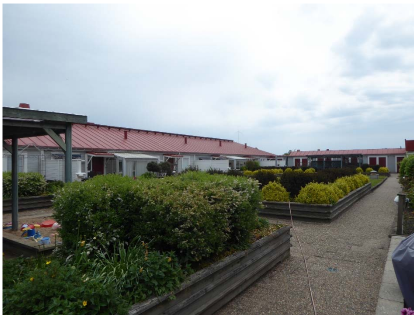
Gårdsmiljön på taket av Flaggenhuset.
