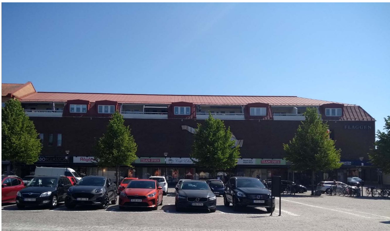
Den västra fasaden med de fem långsmala fönstren till vänster på fasaden.
