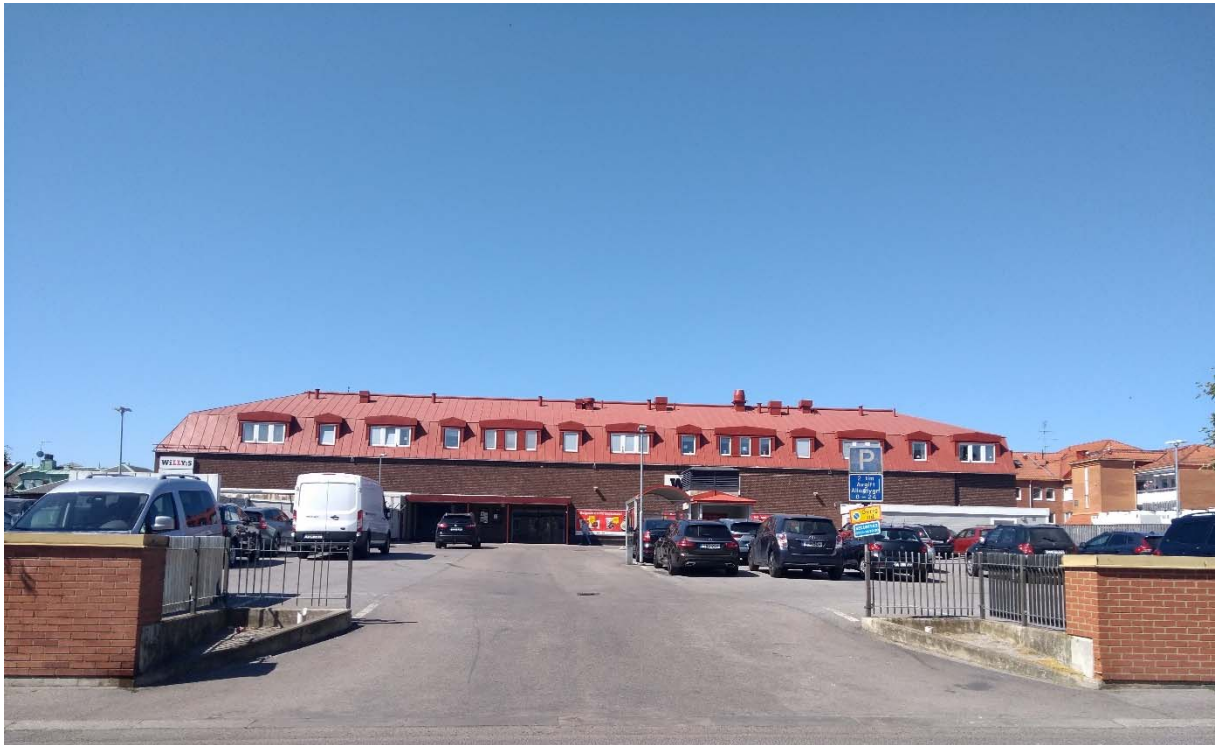
Fasad och parkeringsdäck mot Regeringsgatan
