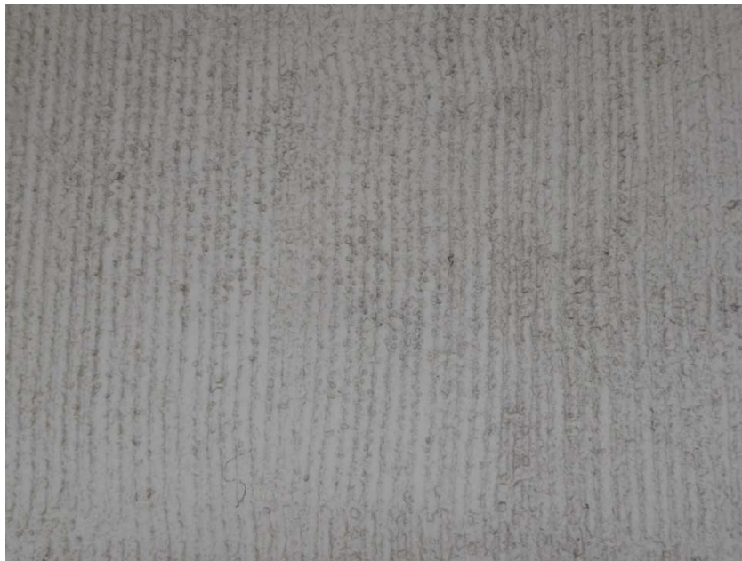
Detalj av den räfflade betongfasaden mot Rådhusgatan.
