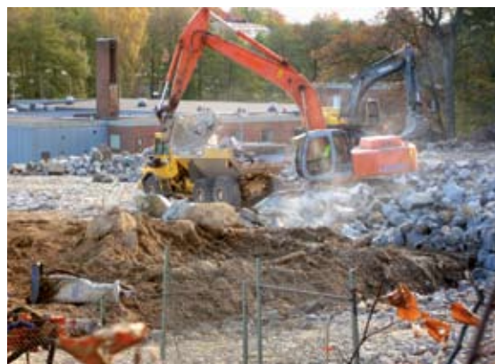
Byggnation av Electro Scandias nya lokaler.
