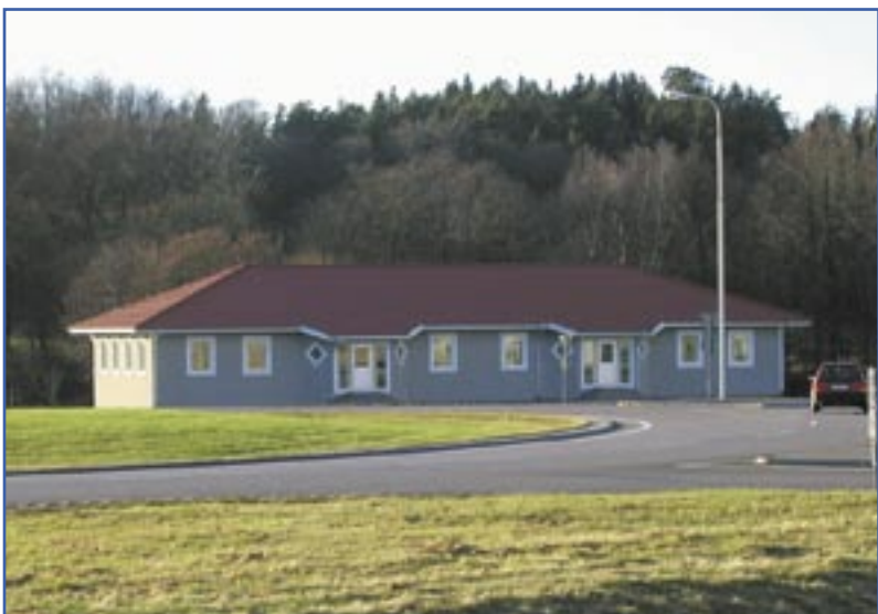
Elautomation Syd AB flyttar i januari in i nya lokaler vid rondellen i Strömma.
