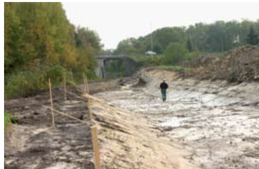
Byggandet av triangelspåret har kommit igång.
