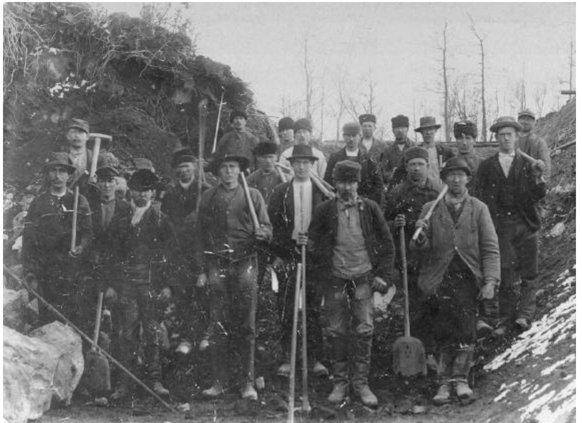
Kanalbyggarna, det mesta arbetet utfördes för hand.
