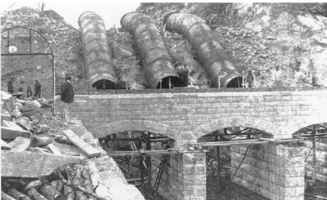
Kraftverket under byggnad
